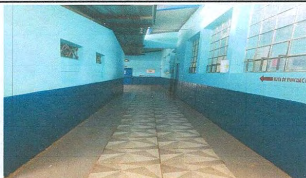
Foto 9: Mejoramiento de piso pasillo
