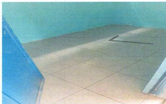
Foto 10: Mejoramiento piso, baños
