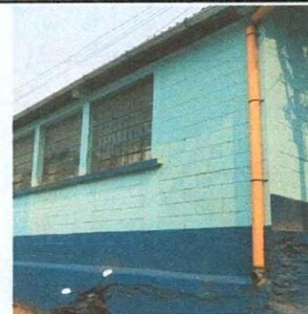
Foto 6: Sustitución de canales en exteriores
