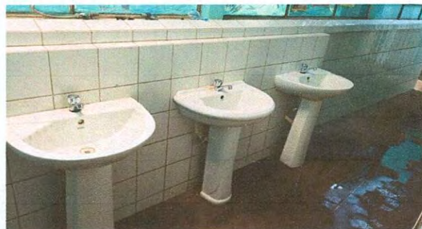
Foto 12: Cambio de lavamanos
