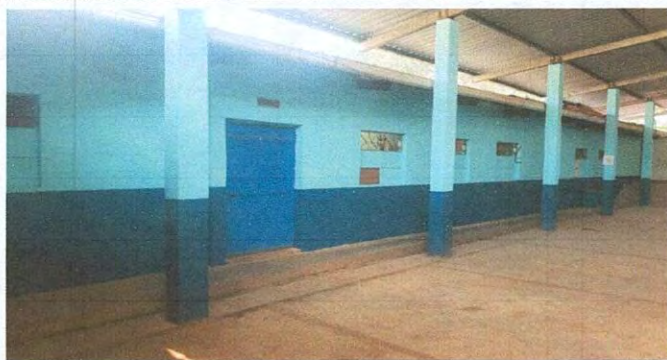
Foto 7: Mejoramiento pasillo salón de actividades
