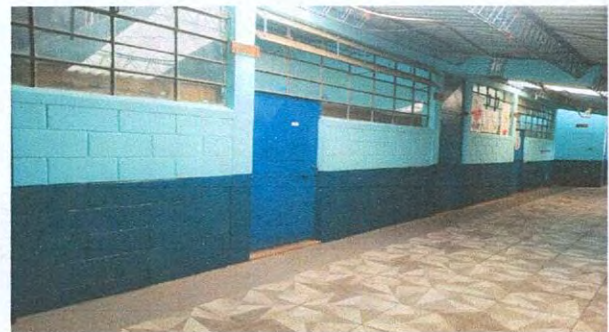
Foto 4: Cambio de piso en corredor
