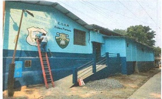
Foto 2: Pintura en muro perimetral exterior finalizado
