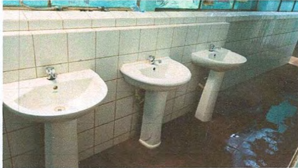
Foto1: Mantenimiento y cambio de llave de lavamanos
